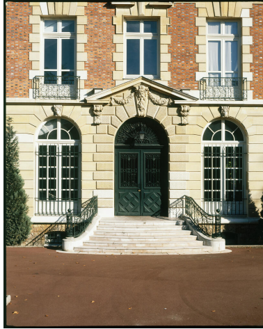
Hôtel Cartier Bresson, puis collège Emile Verhoeren Phot. Philippe Ayrault IVR11_19969200970XA
