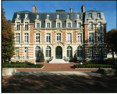
Hôtel Cartier Bresson, puis Collège Emile Verhoeren Phot. Philippe Ayrault IVR11_19969200967XA
